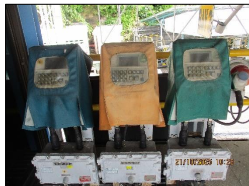
ภาพถ่ายที่ 2.2-2 การติดตั้งระบบการจ่ายน้ำมันแบบอัตโนมัติ (Terminal Automation System/TAS)
