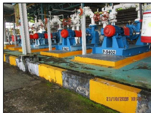
ภาพถ่ายที่ 2.2-3 คันคอนกรีต (Bund Wall) ล้อมรอบบ่อบีและคอมเพรสเซอร์
