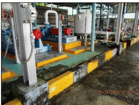
ภาพถ่ายที่ 2.2-3 คันคอนกรีต (Bund Wall) ล้อมรอบบ่อบีและคอมเพรสเซอร์
