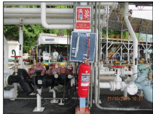
ภาพถ่ายที่ 2.2-4 ข้อกำหนดเรื่องความปลอดภัยในการสูบน้ำมัน และการจัดเตรียมวัสดุดูดซับน้ำมัน
