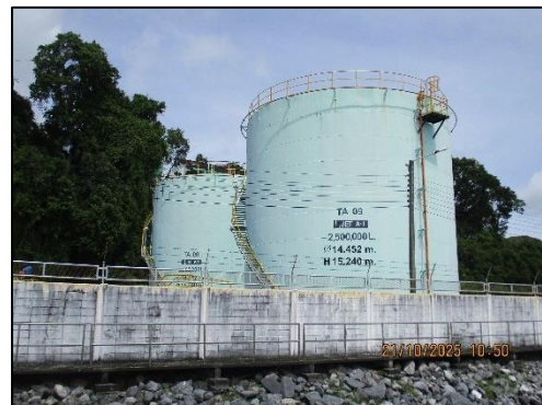
ภาพถ่ายที่ 2.2-1 ถังเก็บน้ำมันสำรองประเภท Floating Roofs
