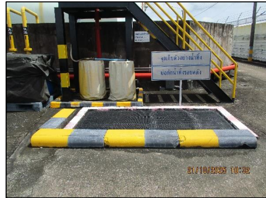
ภาพถ่ายที่ 2.2-7 บ่อตกไขมันและบ่อกักน้ำทิ้งภายในพื้นที่คลังฯ
